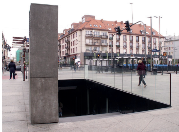
Rys. 3. Podziemno-naziemne Przejście Świdnickie
