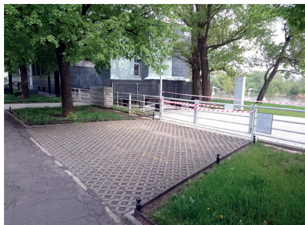
Rys. 9. Ażurowa kostka, którą wyłożono ścieżkę prowadzącą do pochylni na bulwar, znacznie utrudnia dostanie się do tej przestrzeni
