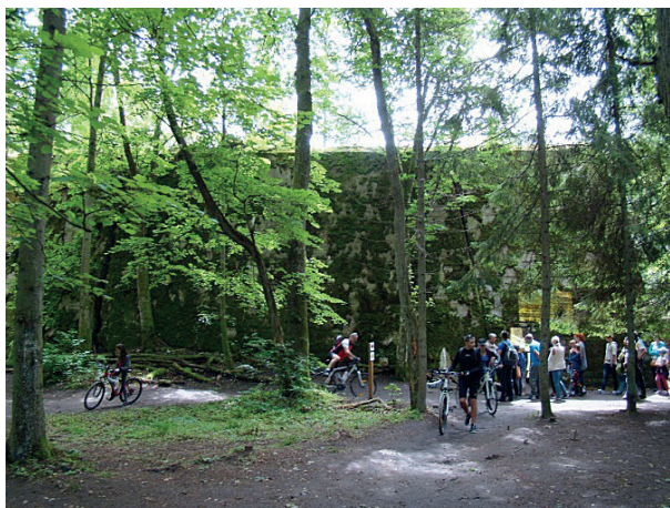
Rys. 3. Zagospodarowanie turystyczne Wilczego Szańca w Gierłozy
