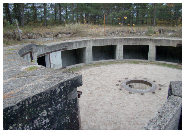
Rys. 1. Wejście do Bunkrów Blüchera w Ustce Źródło: zbiory własne
