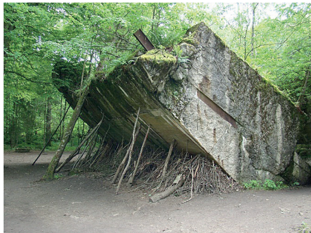
Rys. 4. Stan jednego z budynków Wilczego Szańca w Gierłozy
