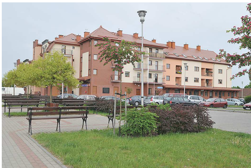
Rys. 10. Zabudowa wielorodzinna w centrum wsi Dywity (gmina Dywity)
