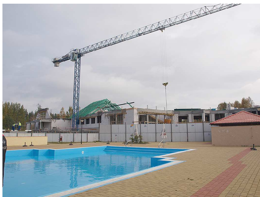
Rys. 8. Budowa hotelu w Worytach w 2011 r. (gmina Gietrzwałd)
