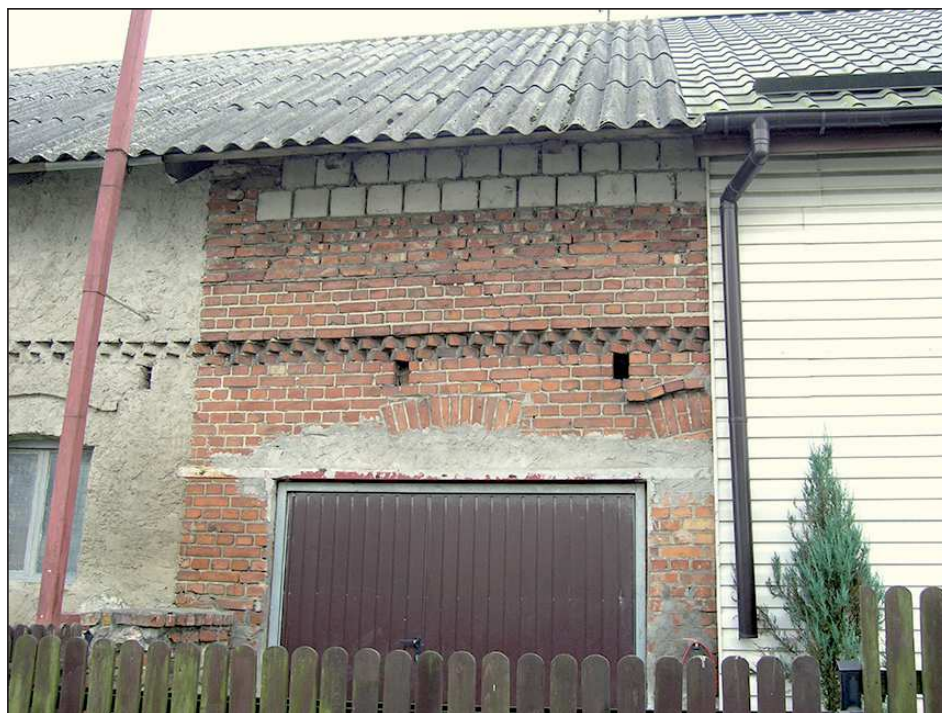
Rys. 1. Przykrywanie ozdobnych fryzów oraz przekształcenia otworów okiennych i drzwiowych, Tyrowo, wrzesień 2011 r. (fot. autor)
