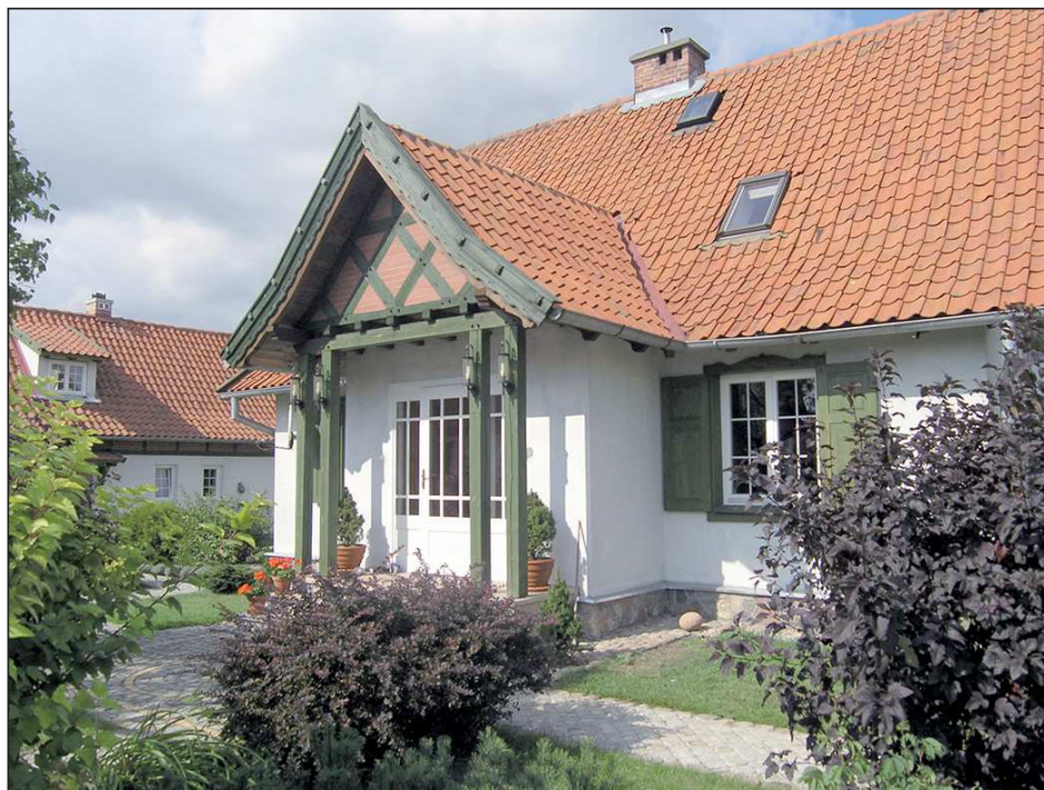
Rys. 5. Pozytywny przykład przebudowy tradycyjnego budynku z początku XX w. z zastosowaniem ozdobnego detalu architektonicznego, Tyrowo, wrzesień 2011 r. (fot. autor)
