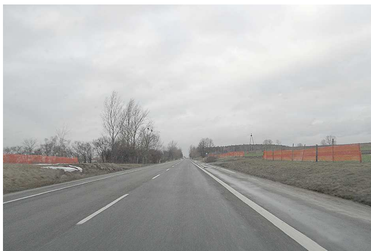
Rys. 1. Sztuczna osłona przeciwśnieżna na poboczu drogi
