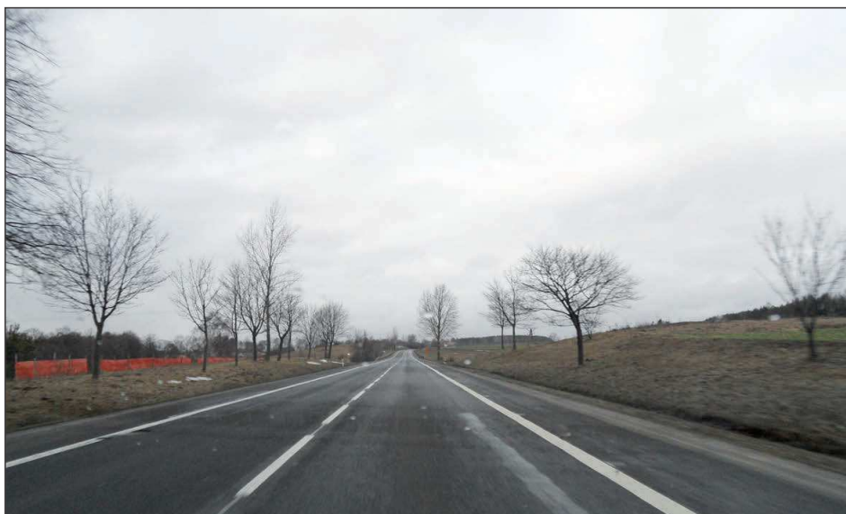
Rys. 1. Charakterystyczny teren otaczający jezdnię narażoną na nawiewy śnieżne wraz z ustawionymi barierami rozbieralnymi
