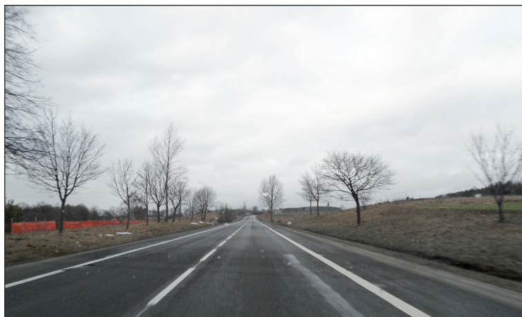
Rys. 1. Charakterystyczny teren otaczający jezdnię narażoną na nawiewy śnieżne wraz z ustawionymi barierami rozbieralnymi
