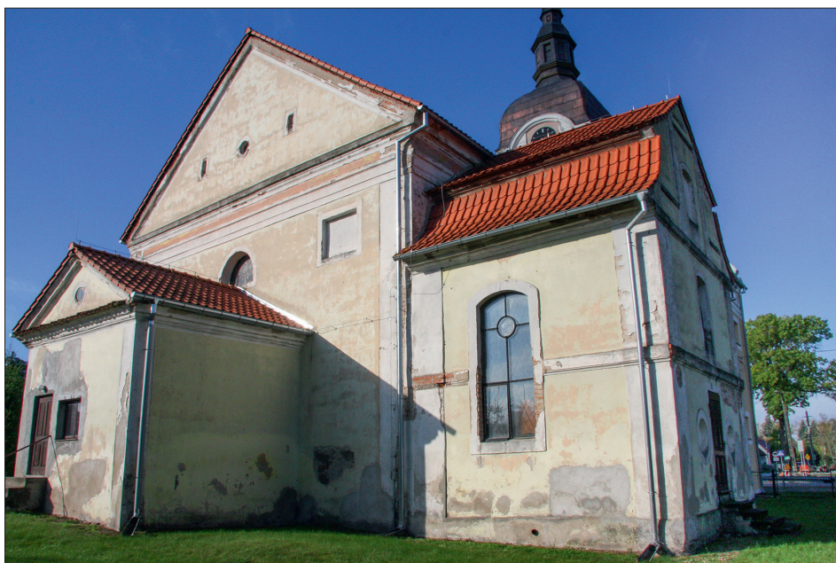
Fot. 2. Widok z tyłu kościoła. Z lewej strony znajduje się dawna zakrystia (dzisiaj kaplica przedpogrzebowa), przylegająca do prezbiterium, a po prawej stronie – kaplica von der Groebenów
