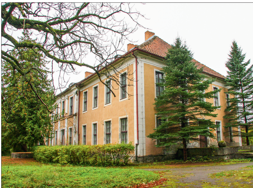
Fot. 7. Pałac w Ponarach – elewacja południowo-wschodnia. Po prawej stronie wejście główne
