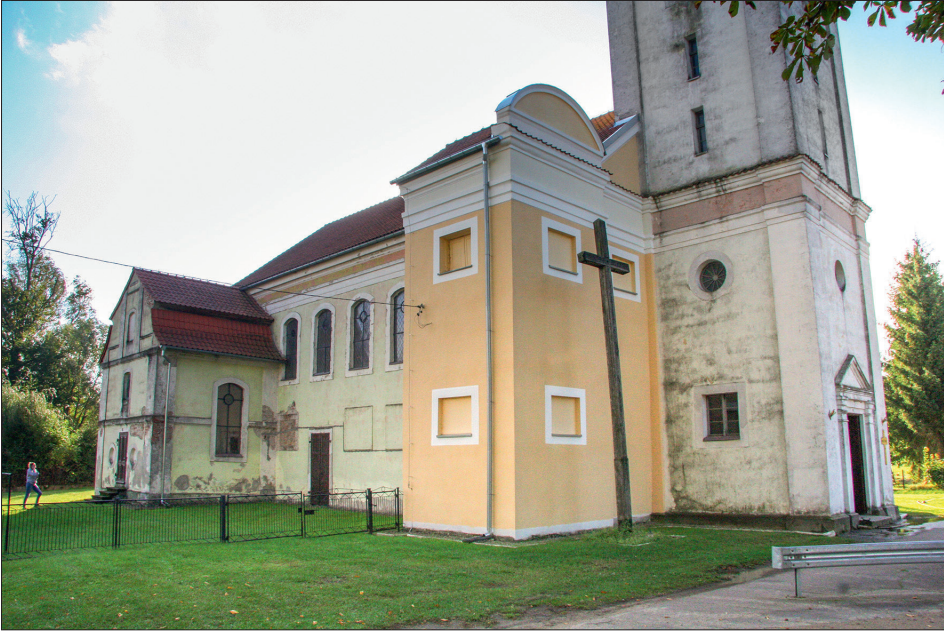
Fot. 1. Północna strona kościoła w Boguchwałach (październik 2020 r.). Z prawej strony widoczna kruchta i wieżyczka schodowa dobudowane w XIX w.; z tyłu, kryta dachem mansardowym, kaplica grobowa Groebenów. Wszystkie zdjęcia pochodzą z prywatnych zbiorów autorki
