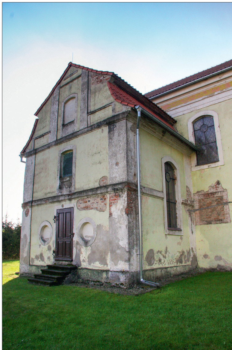
Fot. 3. Kaplica rodu von der Groeben i północna ściana kościoła. Ponad wejściem dwie nisze. W dolnej zachowana tablica epitafijna Marii Luizy
