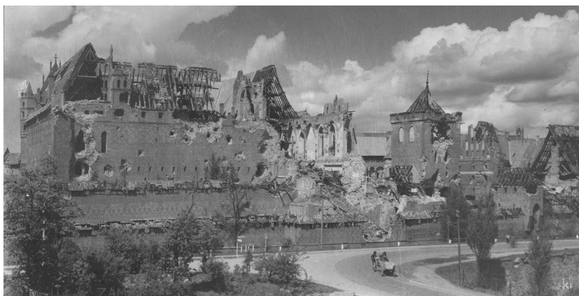
Ryc. 1. Zniszczenia zamku malborskiego w 1945 r. (fot. W. Hodakowski), widokówka z 1946 r.
