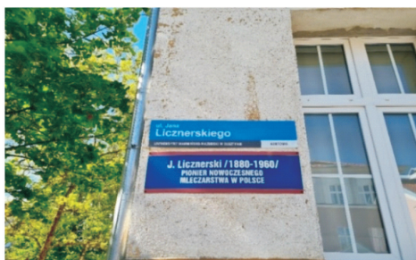
Fot. 14. Tablice na budynku
