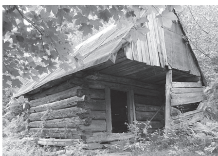
Typ II C. Szopa drewniano-kamienna wooden-stone shed
